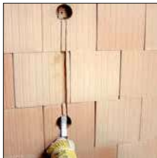
Vorgesägte Schlitzte mit Hammer und Meißel freischlagen.
