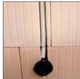
Einlegen der Elektroinstallation in die Schlitzte.
