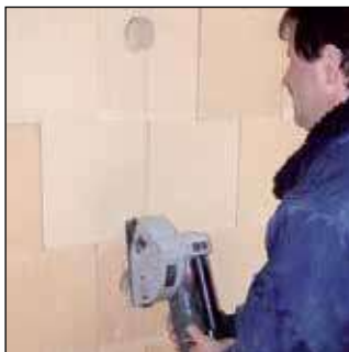
Schlitzten der Ziegel mit der Schlitzfräse.
