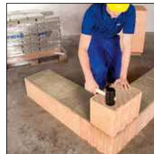
Mauerstein wie gewohnt ausrichten. Fertig!
