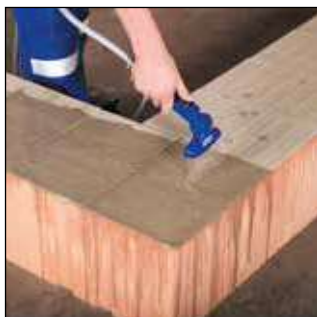
maxit Mörtelpads befeuchten
