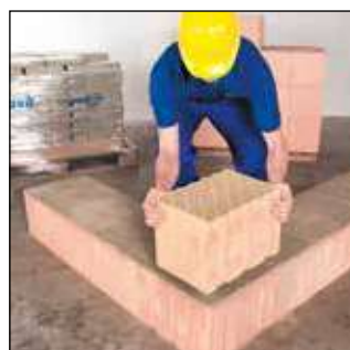
Mauerstein vollflächig auflegen
