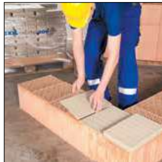
maxit mörtelpads auflegen
