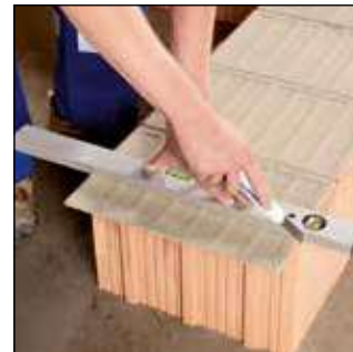
maxit mörtelpads bei Bedarf zuschneiden
