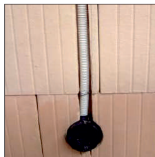
Einlegen der Elektroinstallation in die Schlitzte.
