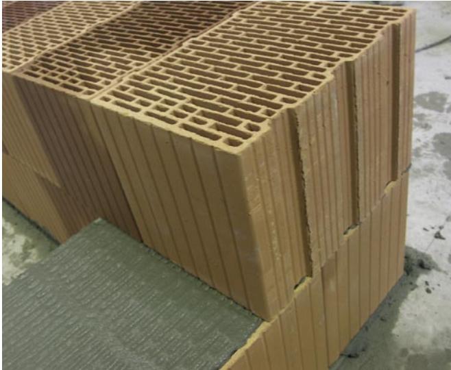
Bilder 2/3: Beispiele für Hochlochziegel mit in Wandlängsrichtung durchgehenden Innenstegen für einschalige Außenwände
